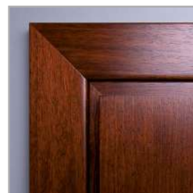
łączenie opasek pod kątem 45°
